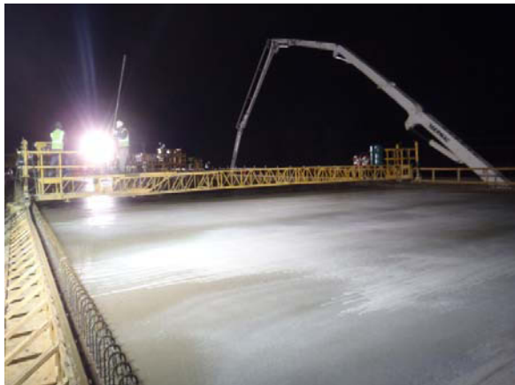
Blockhouse Creek bridge deck pour at night
