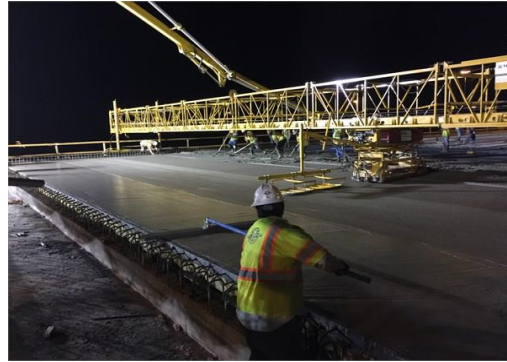
First bridge deck pour over SH 130 (Sept 23)
